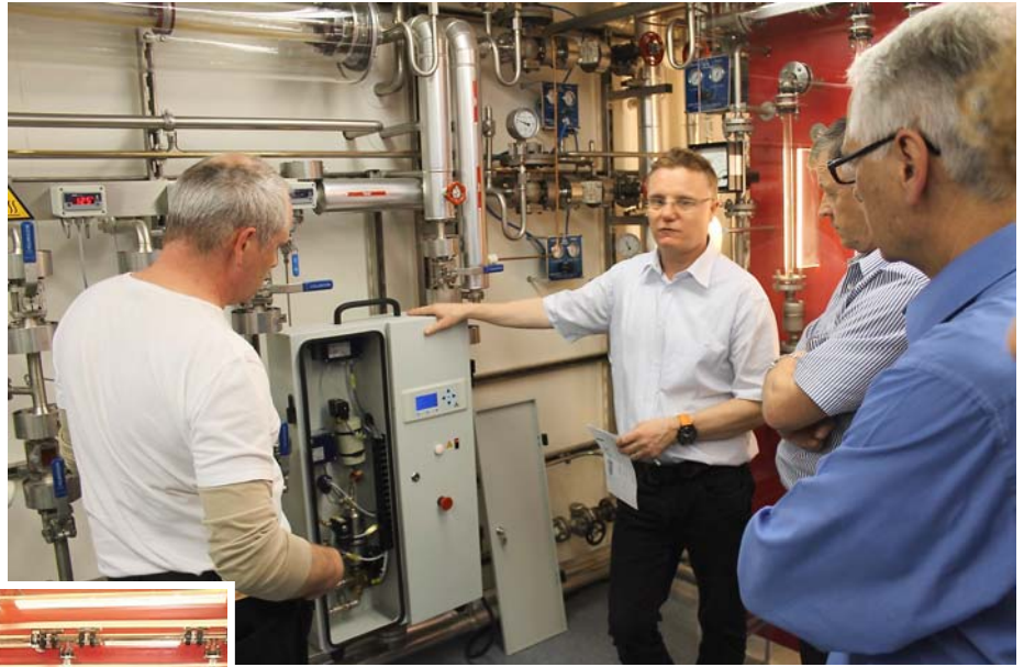
Abb. 2: Die Teilnehmer lauschen interessiert den Ausführungen von Martin Henke zum Reinstdampf-Messgerät QM-3 im technischen Labor.
