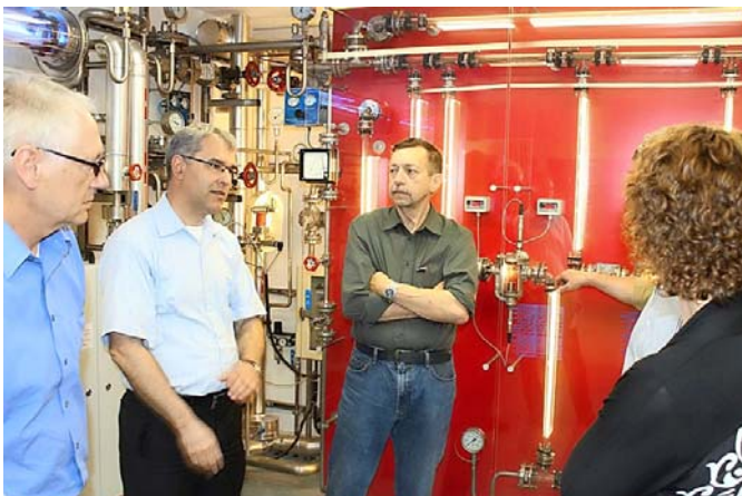
Abb. 3: A. Müller, Bereichsleiter Schulungswesen, demonstriert die Funktionsweise der verschiedenen Kondensatableiter.
